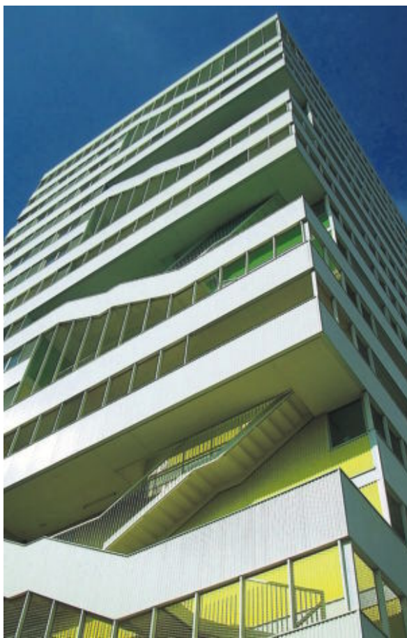
La torre d'habitatges de Via Favència, de 17 plantes, amb les escales a la vista.
